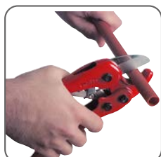
1 - Couper le tube proprement.
