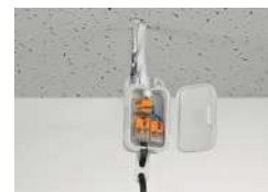
Connexion des luminaires suspendus dans les faux plafonds
