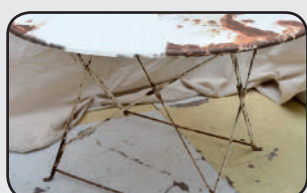
Décaper les surfaces planes Strip flat surfaces
