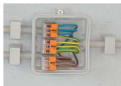
Câblage des conducteurs souples dans des boîtes d'installation.
